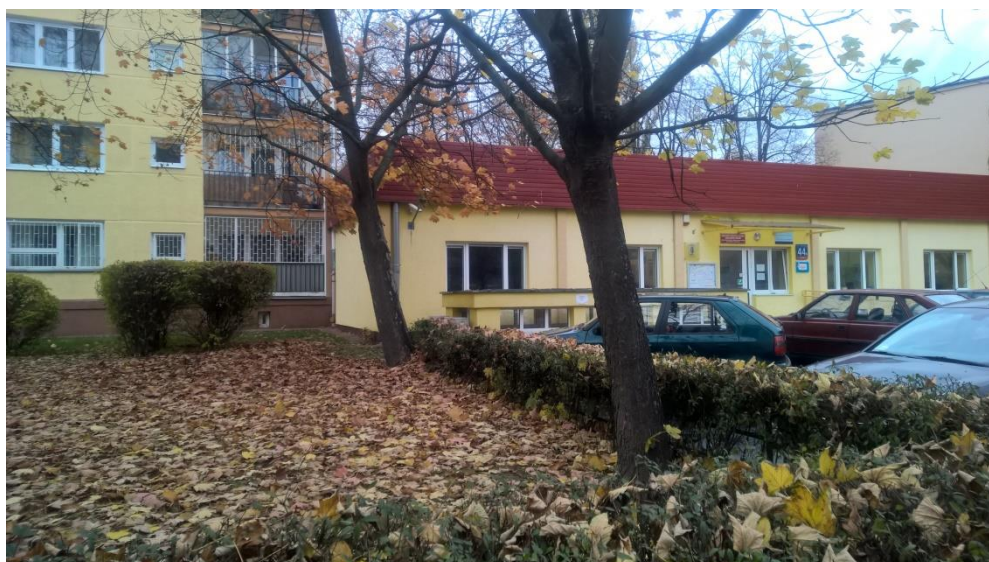
Rysunek 1: widok ogólny na MCIM od strony wejścia
